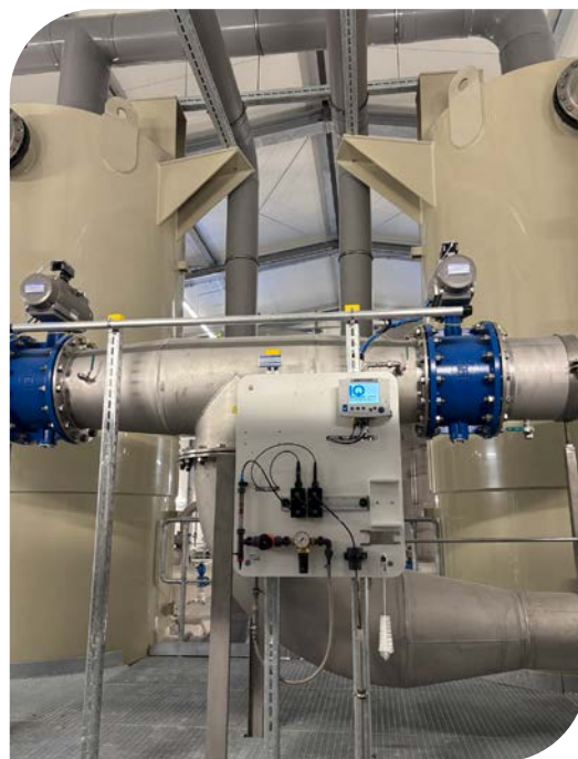
Abb. 3 und 4: Die WTW-Trinkwassertafel überwacht kontinuierlich und zuverlässig die Wasserqualität im Wasserwerk Osthofen (oben vor der Riesleranlage, unten im Ablauf der SEC-Anlage)
